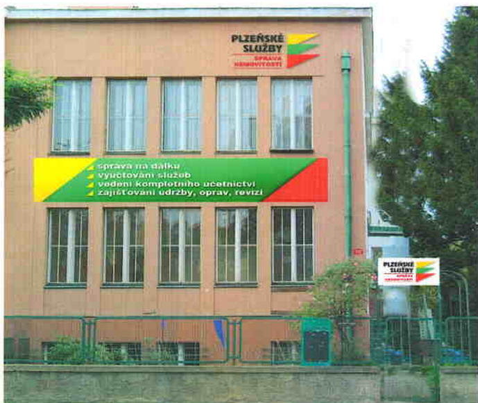
Objekt pravé poloviny růžové vily z pohledu zády k Poště 12 z Masarykovy ulice v Plzni – Doubravce, vchod z Masarykovy ulice, Adresa: V Malé Doubravce 30, 312 00 Plzeň
